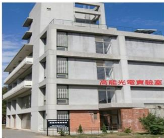
|高能光電實驗室|
